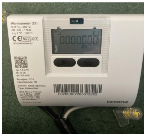
Dit is de meter waar je de warmte-afname (stadswarmte) afleest, aangegeven in gigajoule.
