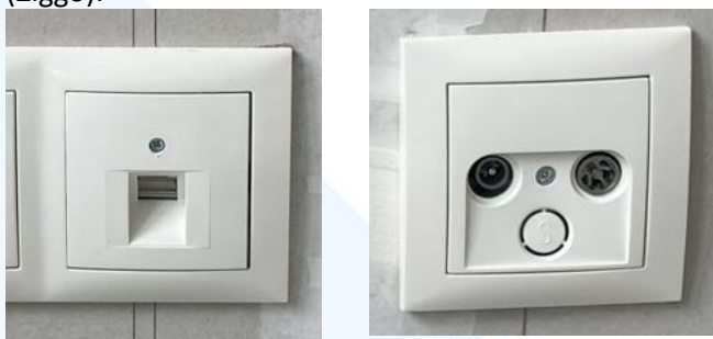
In de woonkamer zit een bedraad data-punt en een bedrade tv-aansluiting
