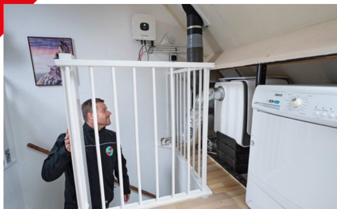
Tom Noij bekijkt de werkzaamheden in Leuvenbroek.
