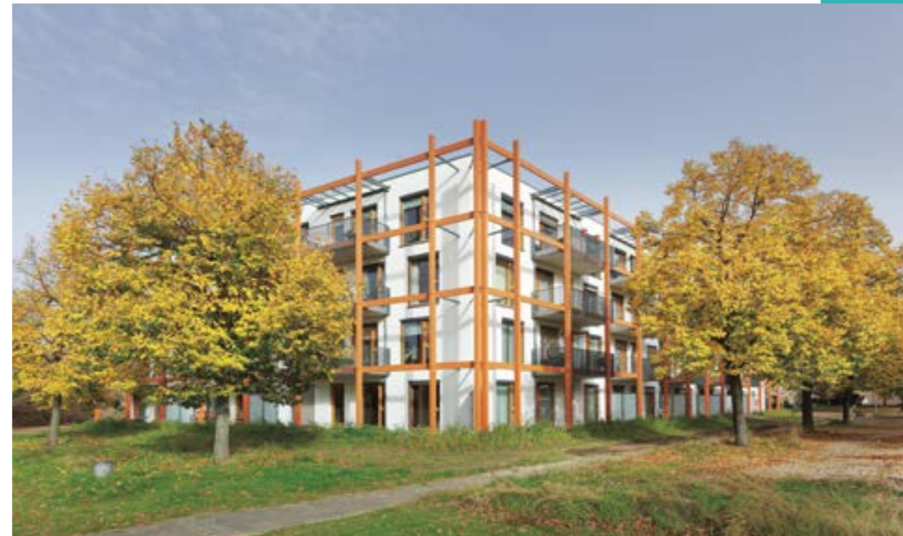
Appartementengebouw De Oogst
