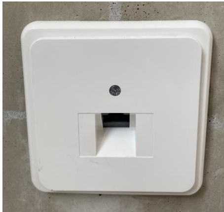
In de woonkamer zitten diverse bedrade data-punten voor bijvoorbeeld de tv-aansluiting
