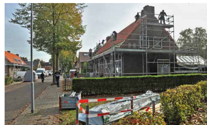
Alle daken worden geïsoleerd en krijgen nieuwe dakpannen.
