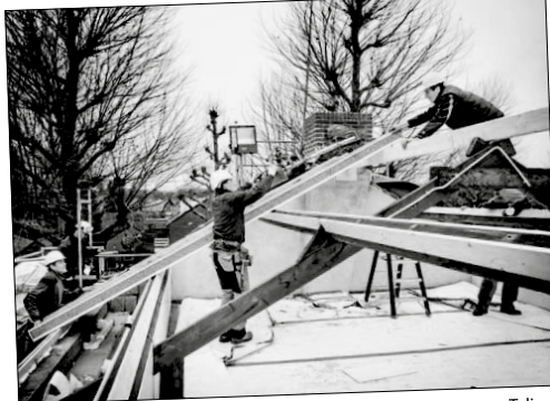
■ Bouwvakkers brengen isolerende platen aan bij woningen van Talis aan Uilenboom in Wijchen, eind 2013. De woningbouwvereniging wil zo de energiekosten van huurders drukken. archiefphoto Eveline van Elk
