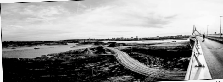
■ Panorama van het 'nieuwe' stadsgezicht van Nijmegen met links de nevengeul in aanleg en rechts de nieuwe stadslaan (foto: Nijmegen van der Zalm/DG)
