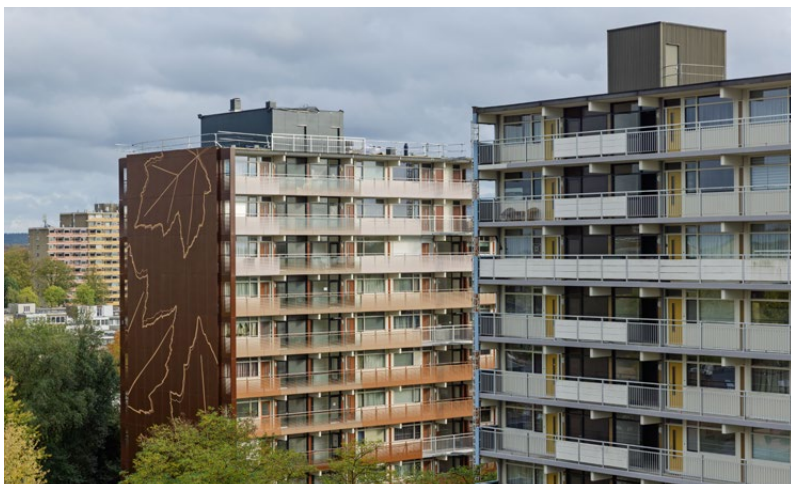
Renovatie 453 woningen in Zwanenveld (Nijmegen)
